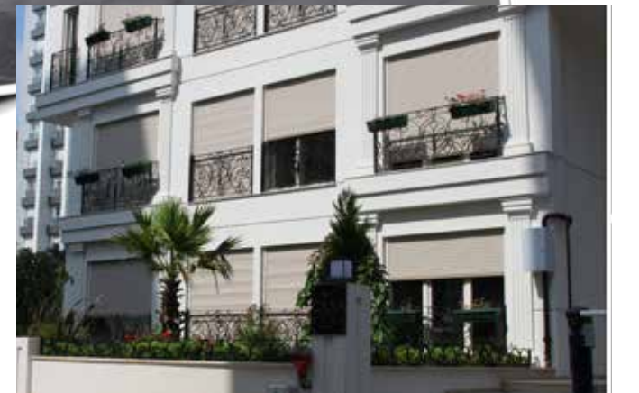
TEMEL İNŞAAT / EYÜP PAŞA SOKAK
